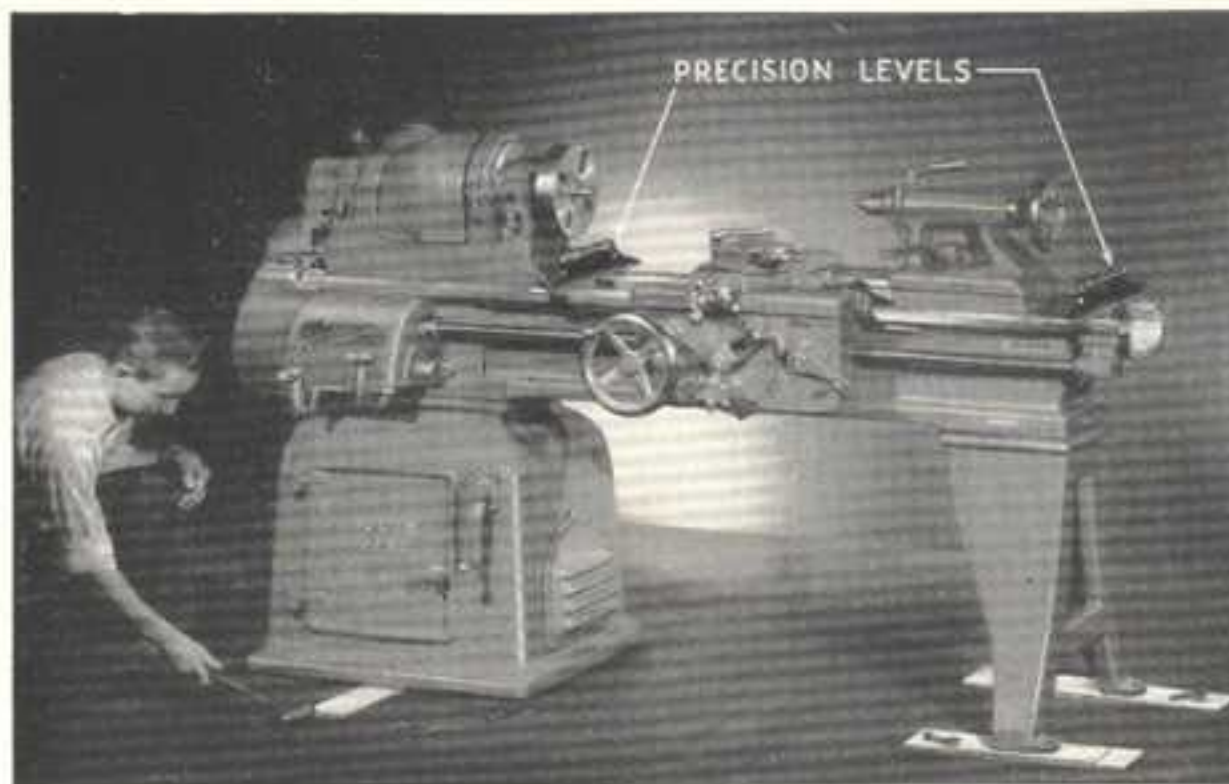
Fig. 23. Leveling the Lathe
